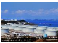
沖縄石油備蓄基地
