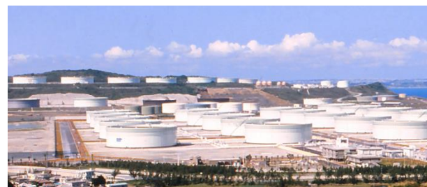
沖縄石油備蓄基地
