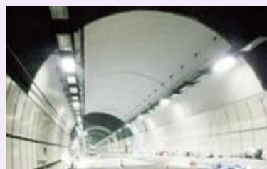
水性の不燃性塗料によるトンネル内コンクリート片はく落防止技術
